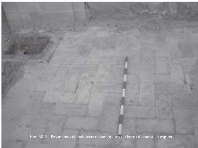
Fig. 50D - Pavimento de baldosas rectangulares de barro dispuesta a espiga
